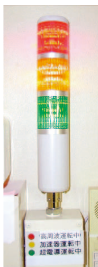
パイロットランプ三色燈 赤色点滅灯は高電圧・強磁場，青色点滅灯は高圧ガス製造施設または高周波加速空洞（KEKB区域）運転中を知らせる。
