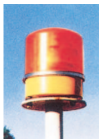
パイロットランプ(黄色) 点滅して加速器等放射線発生装置の運転を知らせる。
